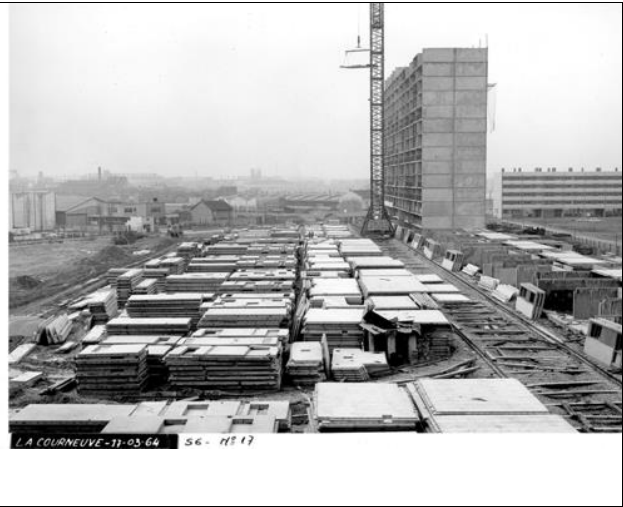
La construction de la cité des 4 000 à La Courneuve
