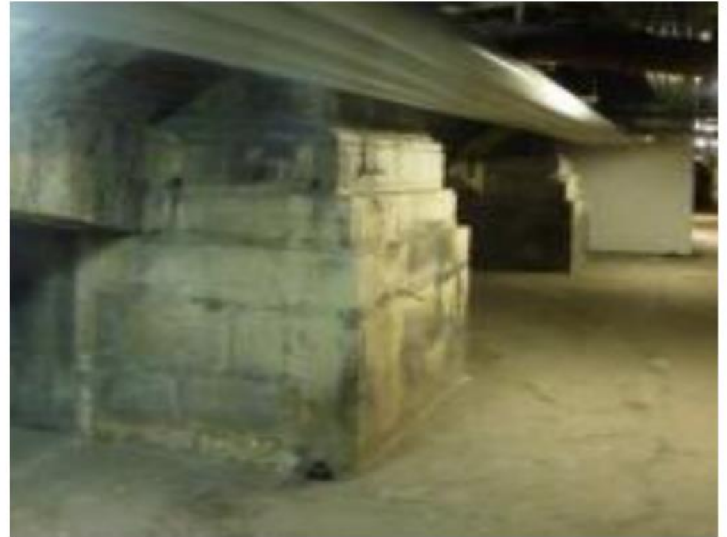
Base des arcades du logis du roi côté cour Saint-Martin, état actuel
