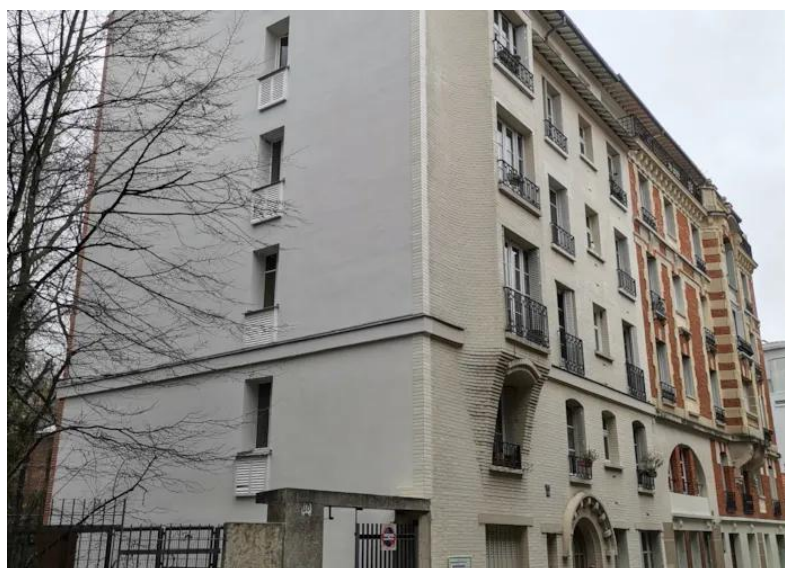
Un bâtiment du 20e siècle rénové de l'extérieur avec de l'isolant biosourcé rue de la Réunion, dans le 20e. Crédits : Coach Copro.
