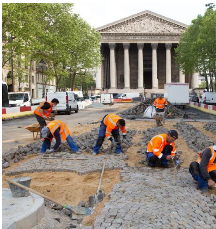
Pavage de la rue Royale, 8ème - Les travailleurs de la construction et des travaux publics sont particulièrement exposés à la chaleur. Des arrêts de chantier sont à anticiper en période de canicule. (Crédits Christophe BELIN / Ville de Paris)
