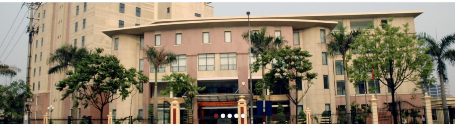
Centre des Archives nationales du Vietnam à Hanoi
