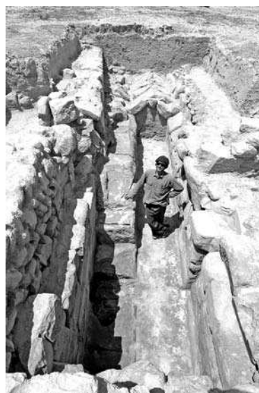
Fig. 9 - Qasr al-Hayr al-Sharqi : moulin hydraulique placé sur l'aqueduc arrivant d'al-Kawm (photo Denis Genequand).
