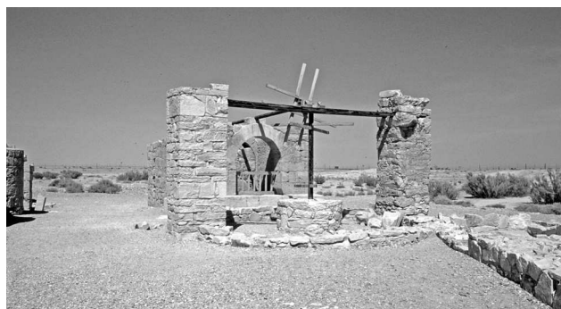
Fig. 20 - Qusayr 'Amra : le puits, le système d'élévation de l'eau et la citerne devant l'entrée du bain (photo Denis Genequand).
