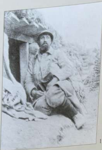
1 Le sergent M. devant son trou, tranchées de 1 re ligne.
