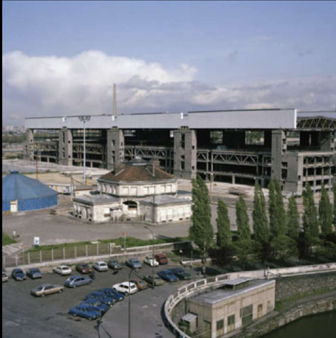
Structure évidée du magasin des ventes
