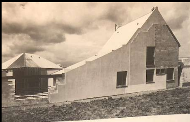
GRUPE SCOLAIRE « LES RÉGALLES » - ALLÉE DES ALOUETTES 77176 SAVIGNY-LE-TEMPLE - STANISLAS FISZER, ARCHITECTE - 1980
