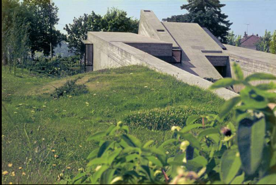
Maison Delbigot, Villeneuve-sur-Lot, 1970-1972
