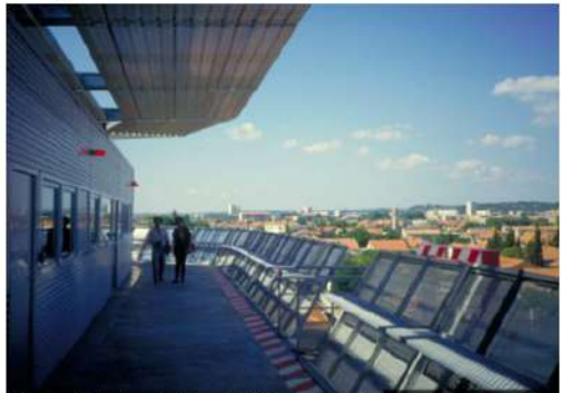
Vue depuis le dernier étage du bâtiment court
