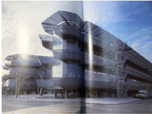
Vue depuis la rue Vistre sur les deux bâtiments
