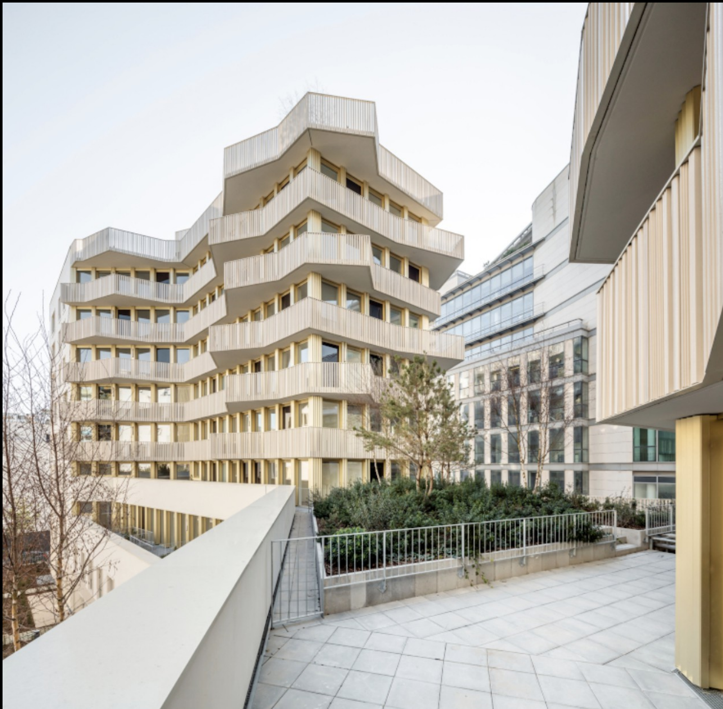
Ilot Fulton, Paris Rive-Gauche, 2018 (immeuble AFJA)
