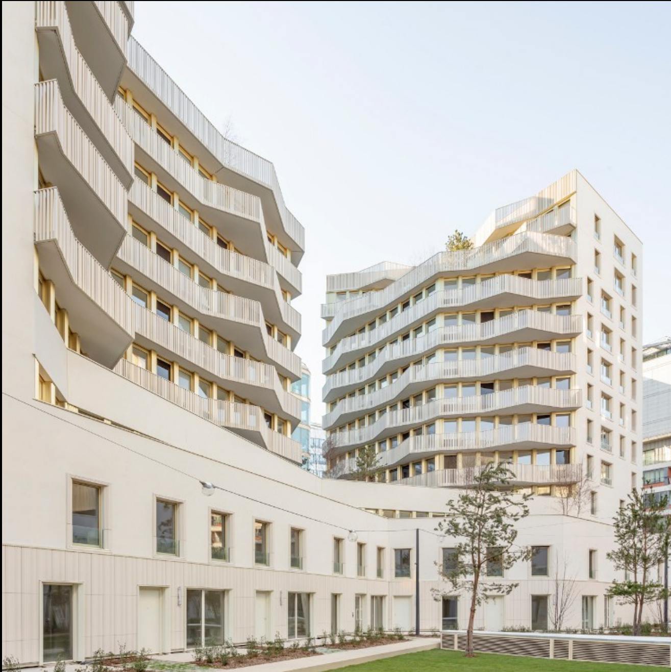
Ilot Fulton, Paris Rive-Gauche, 2018 (immeuble AFJA)
