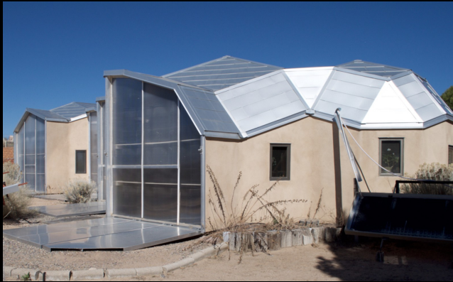
Steve Baer, Baer House, Nouveau Mexique, 1972
