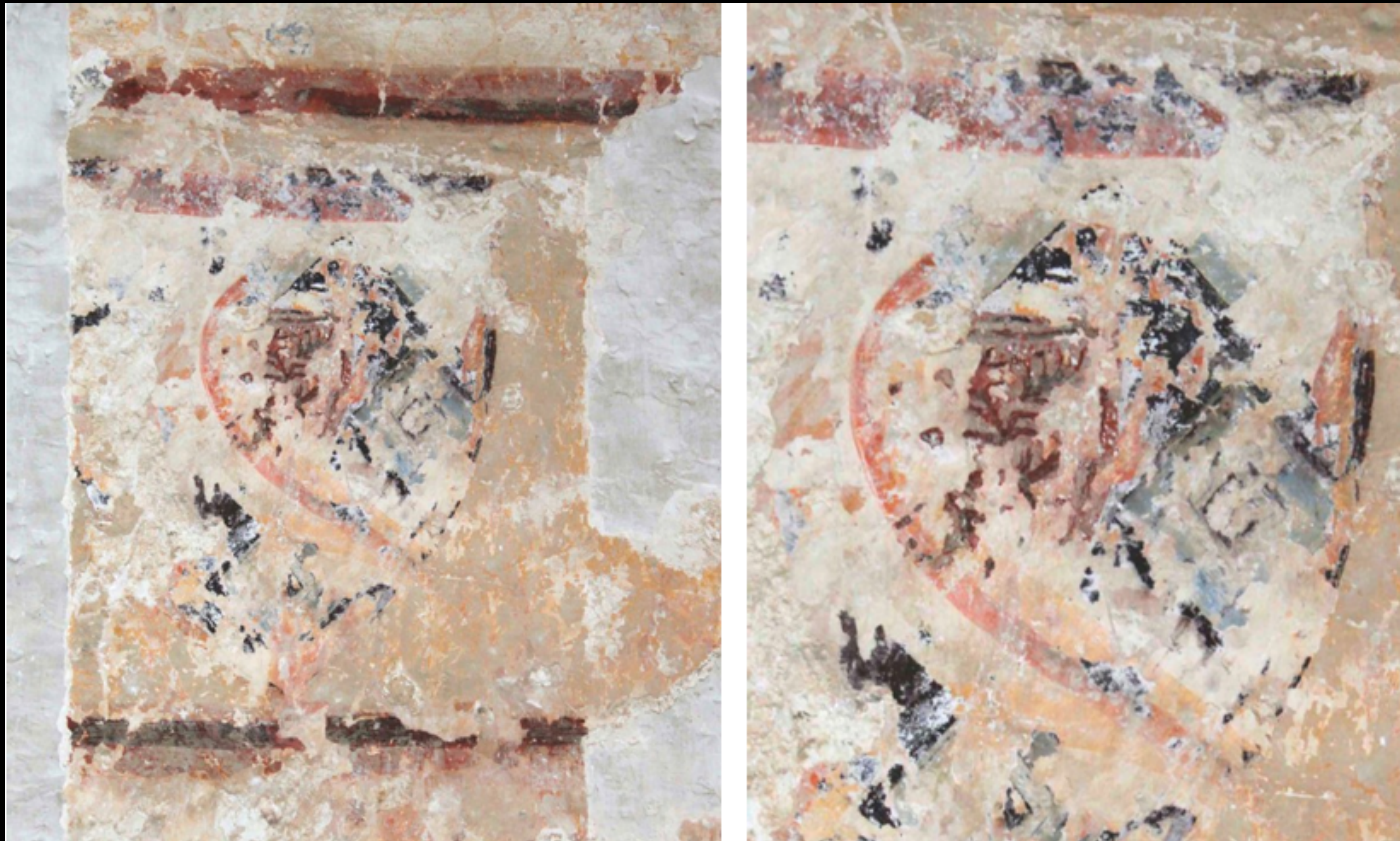
Mur sud, armoiries très dégradées montrant le décor sous-jacent
