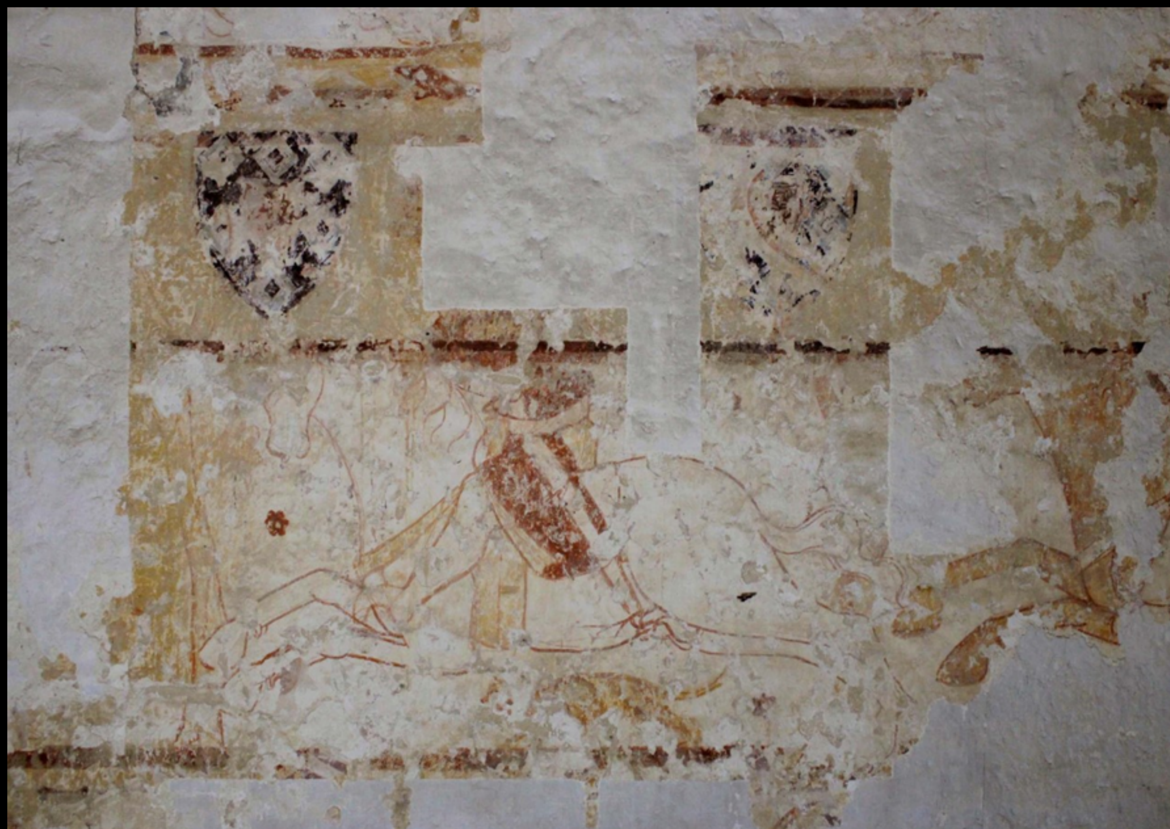
Mur sud, vue générale après homogénéisation des zones mises au jour (régularisation des limites et enlèvement des plages et résidus des badigeons)
