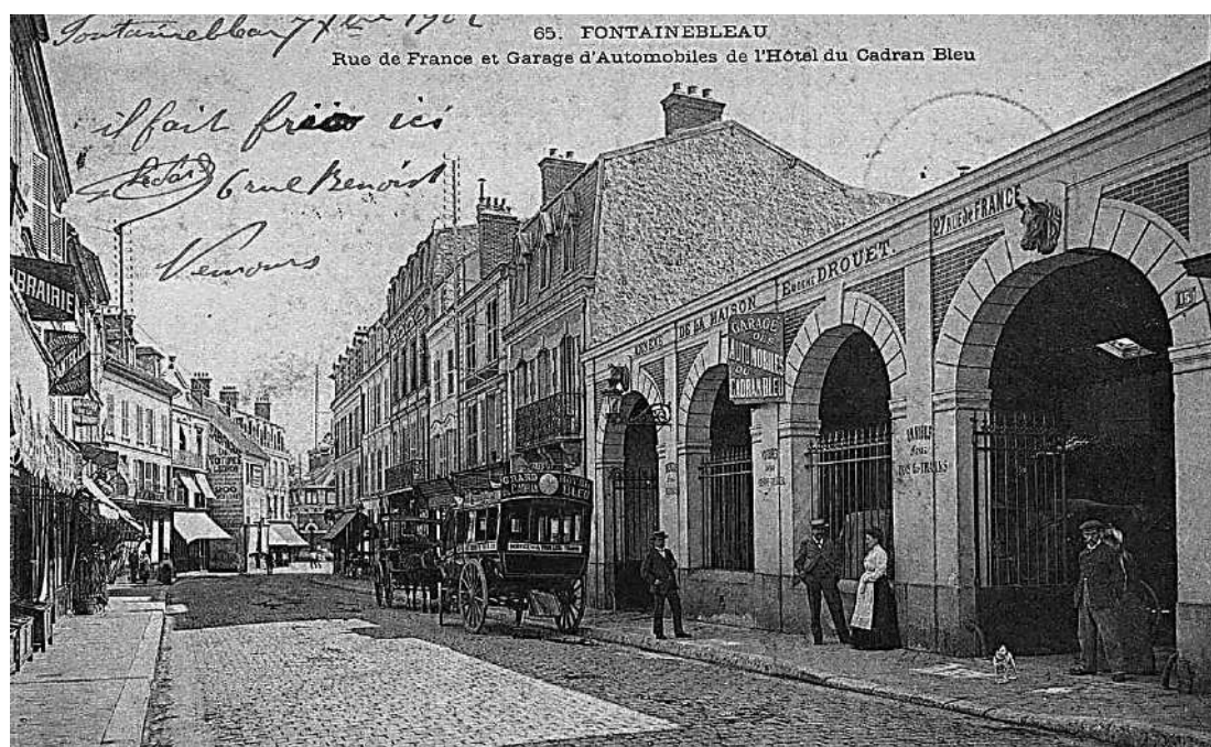
Figure 17 : Fontainebleau. Rue de France et garage d'automobiles de l'Hôtel du Cadran Bleu, 1902. Archives de Seine-et-Marne (2FI3135).
