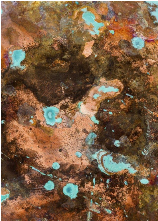
La corrosion du cuivre
